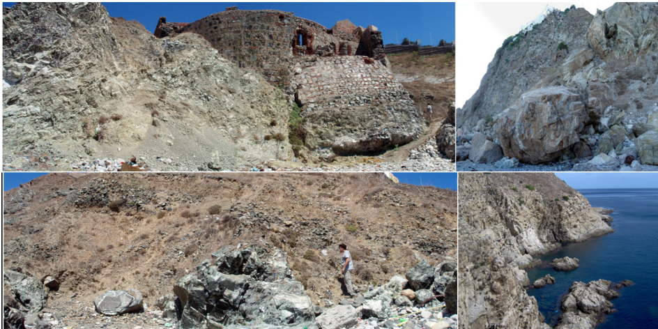
Arriba izquierda, deslizamiento en la antigua cárcel de mujeres, en el Sarchal. Arriba derecha, caída de bloques y rocas en playa Sarchal. Abajo izquierda, coluviones y otros depósitos de ladera en la playa del Sarchal. Abajo derecha, acantilados próximos a la Punta de la Palmera, en el Monte Hacho.
