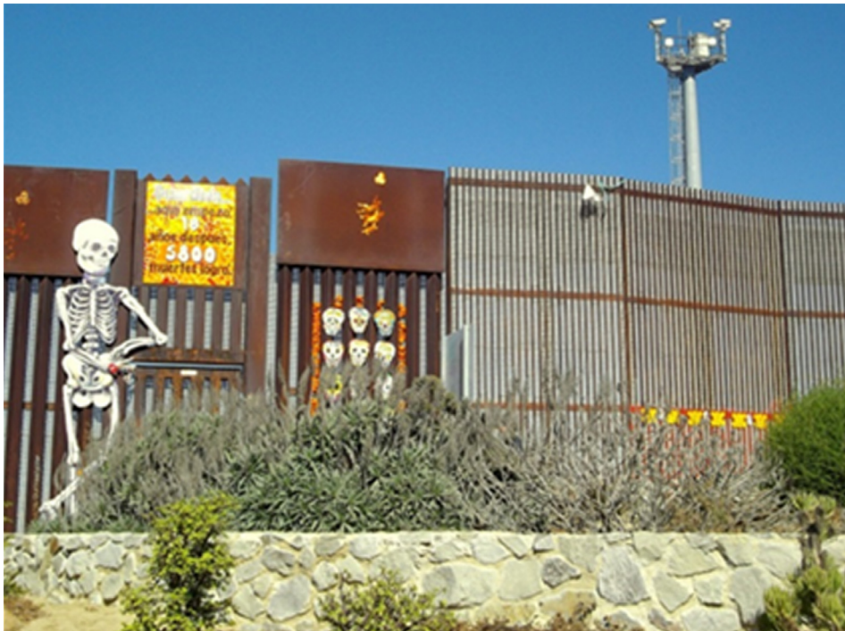
Imagen 8. Valla fronteriza en Tijuana, y homenaje en el “Día de Muertos” a las víctimas desde la construcción del muro hasta 2012.
