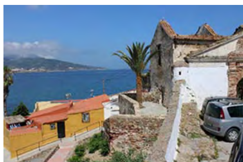
Problemas de accesibilidad generalizada.
