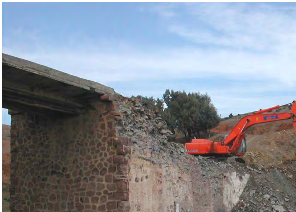
Figura 1. Derribo del puente de la desaparecida línea de ferrocarril Ceuta-Tetuán.
