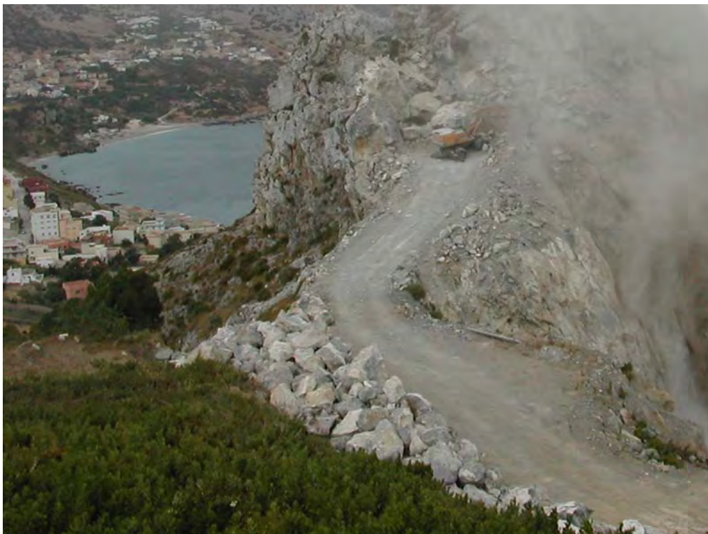
Figura 8. Voladuras en el Mogote de Benzú.
