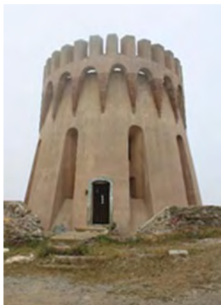
Estado general del elemento.
