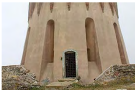
Cerrajería y revestimientos en buen estado.
