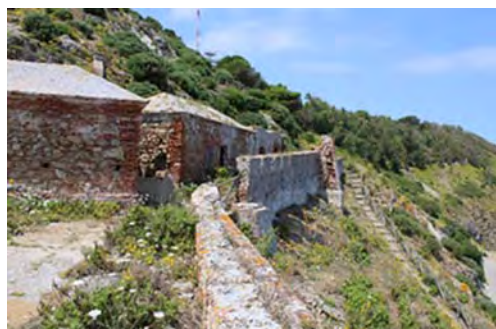
Edificación en ruina.
