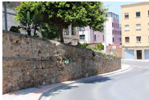
Elementos de instalaciones.
