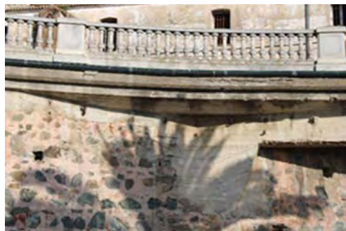
Elemento en buen estado.
