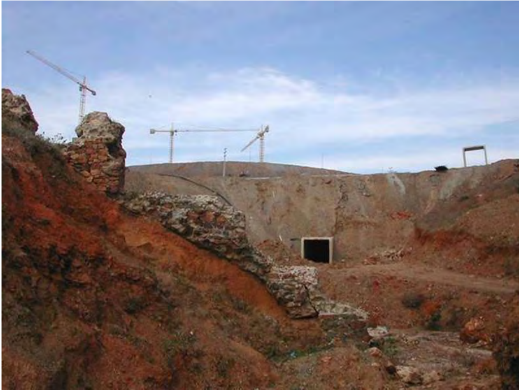
Figura 2. Afectación del entorno de acueducto romano de Arcos Quebrados.
