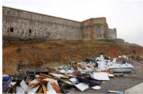
Presencia de restos y basuras.
