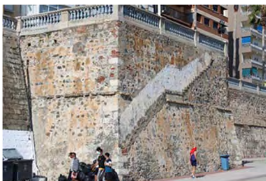
Actualmente se encuentra en proceso de rehabilitación.
