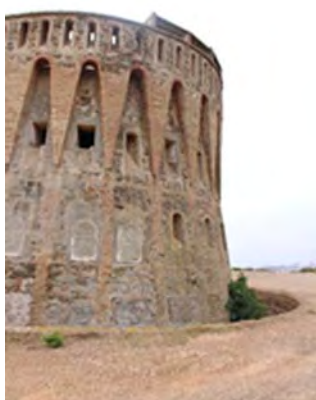
Cobertizo añadido en cubierta
