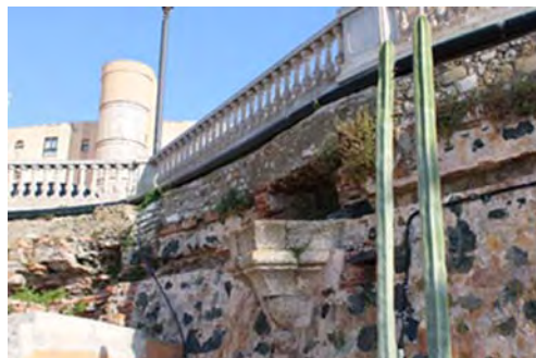
Parte superior de la batería.
