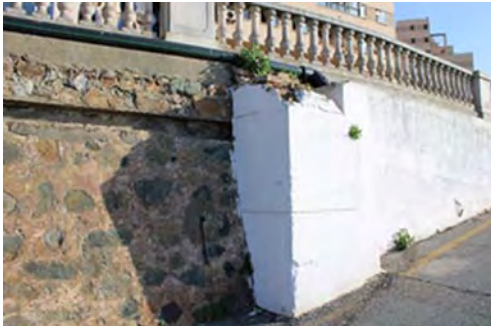
Línea de instalaciones.
