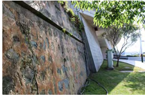
Problemas con las instalaciones del lugar.
