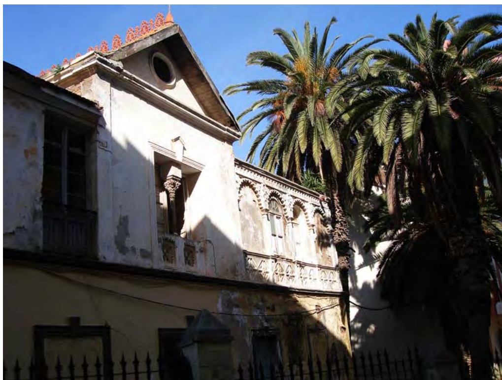
Figura 12. Edificio de estilo neoárabe situado en la calle Ramón y Cajal antes de su derribo.
