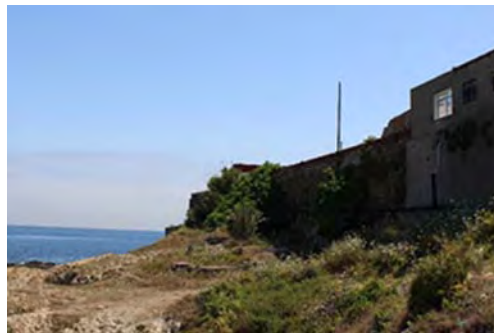
Crecimiento excesivo de vegetación existente.
