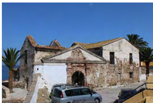
Imagen general del conjunto; se aprecian las carpinterías en estado de ruina.
