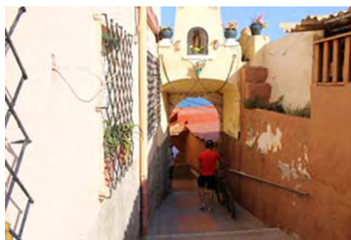
Desprendimientos de revestimientos.
