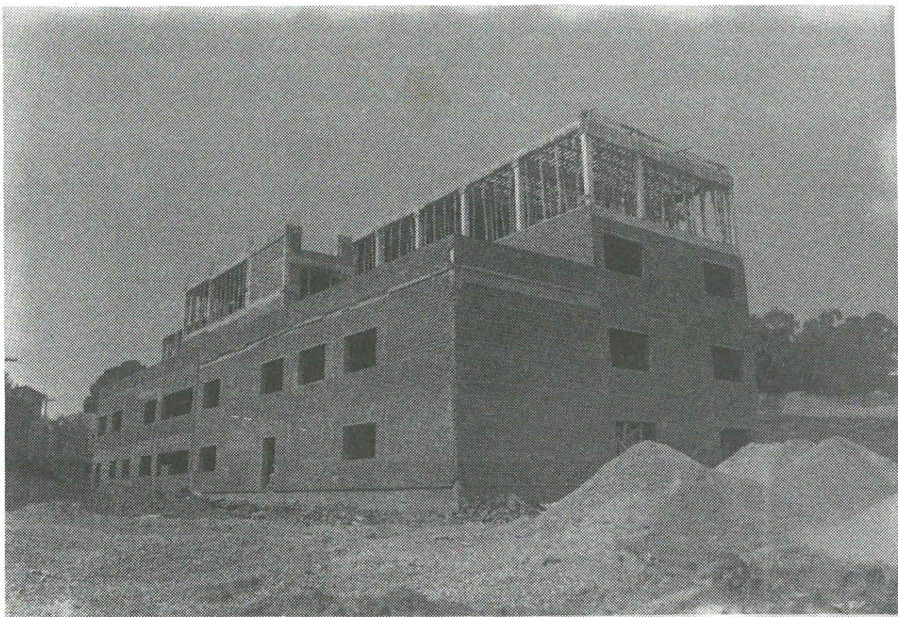
Perspectiva de la nueva construcción que realiza Cáritas para atender a la Población Subnormal de Ceuta.
