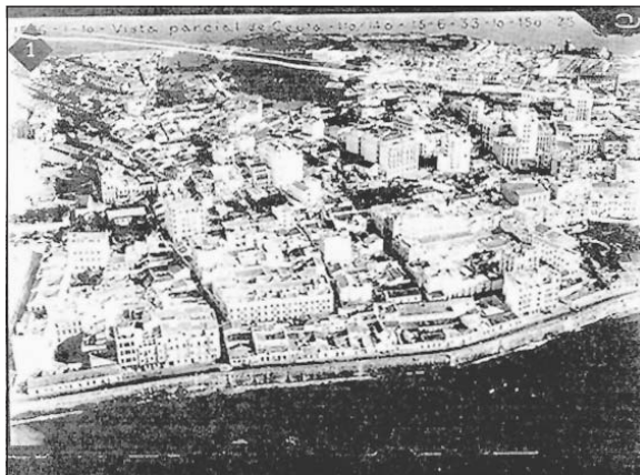
1.- VISTA AÉREA DEL PASEO DE LA MARINA HACIA 1933. 2.- VISTA DE CEUTA HACIA 1923, EN LA IMAGEN SE PUEDE VER LA CONSTRUCCIÓN DEL PUERTO, LA EMPRESA DE YBARROLA Y EL CAMPO DE FÚTBOL DE LA HÍPICA, DONDE DIEZ AÑOS DESPUÉS SE INAUGURARÍA EL CAMPO MUNICIPAL "ALFONSO MURUBE".
