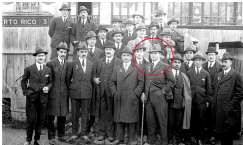
Visita de César Cort (5) y otros profesores de la Escuela Superior de Arquitectura de Madrid, entre ellos Teodoro Anasagasti (4), con sus alumnos a las obras del Metropolitano de Madrid en 1918. Archivo fotográfico del diario ABC .
