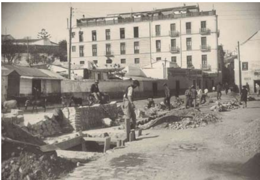
La Almina. Canalización subterránea de telefonía en la plaza de Azcárate, Luis Ramón Marín, entre 1924-1931. Archivo Fotográfico de Telefónica.
