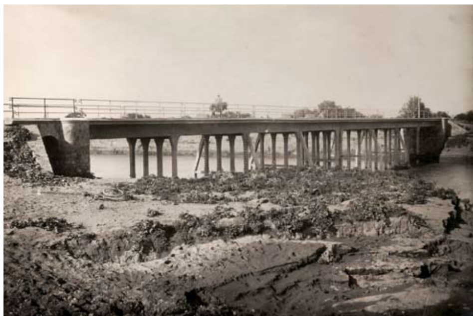
Puente del Negro (arriba) y puente sobre el río Martín (abajo) en el recorrido del ferrocarril Ceuta-Tetuán en 1918. Real Biblioteca, Patrimonio Nacional, Madrid.
