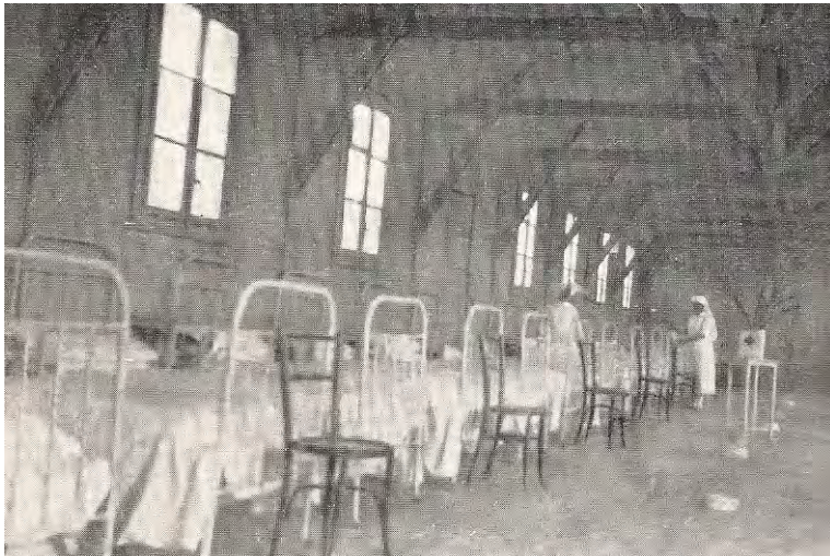
Interior del Barracón de tropas.
