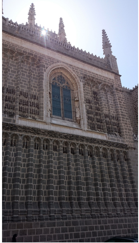
Figura 3. Cadenas en la fachada de San Juan de los Reyes (Toledo). Foto del autor.
