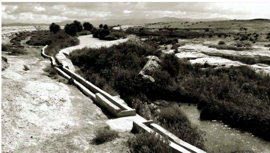
Presa de retención, Tighmert, Guelmim (Marruecos)
